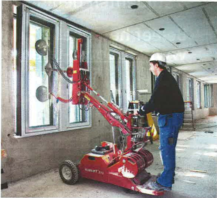
Personeel van Duco Monbouw plaatst de kozijnen van de Jubi-torens van binnenuit met een glaslift. Foto: Peter van Mulken
