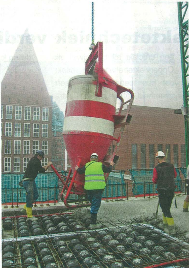
De vierkuubs kubel aan het werk op de JuBi-bouwplaats.
