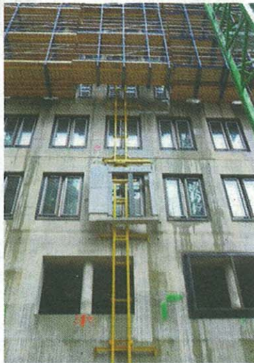
De rijdende montage-unit is veel veiliger dan gangbare hijsmethoden.
