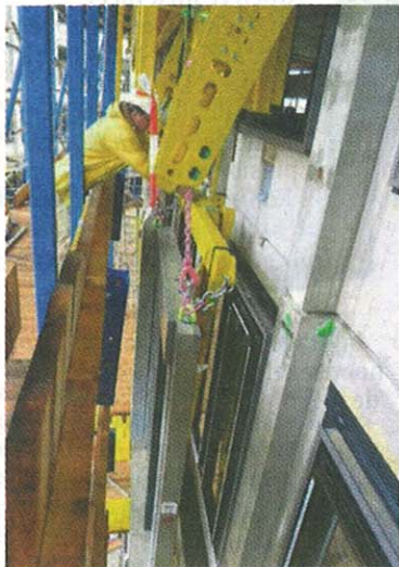
De rijdende montage-unit is veel veiliger dan gangbare hijsmethoden.
