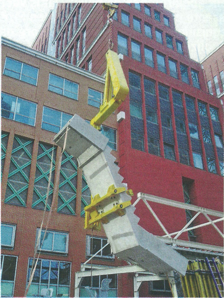
Een trap met bordessen en al hangt in een trappensteller.
