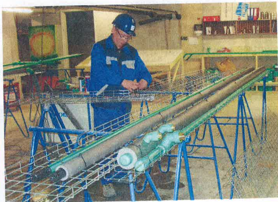
Installatiedelen worden geprefabriceerd in een kelder-ruimte van één van de Jubi-torens.
