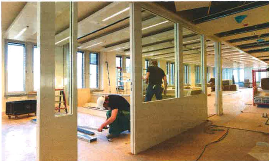
Personeel van Bruynzeel Interfinish monteert één van de gangwanden in een JuBi-toren. Foto: Peter van Mulken
