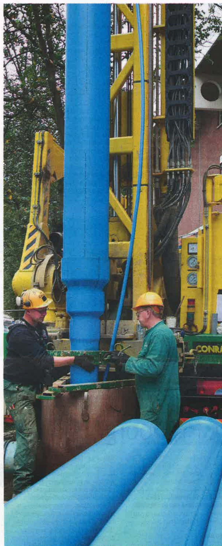
Medewerkers van Haitjema plaatsen blauwe kunststof filterbuisen, met doorsnedes van 250 millimeter onder tot 400 boven in het boorgat.
